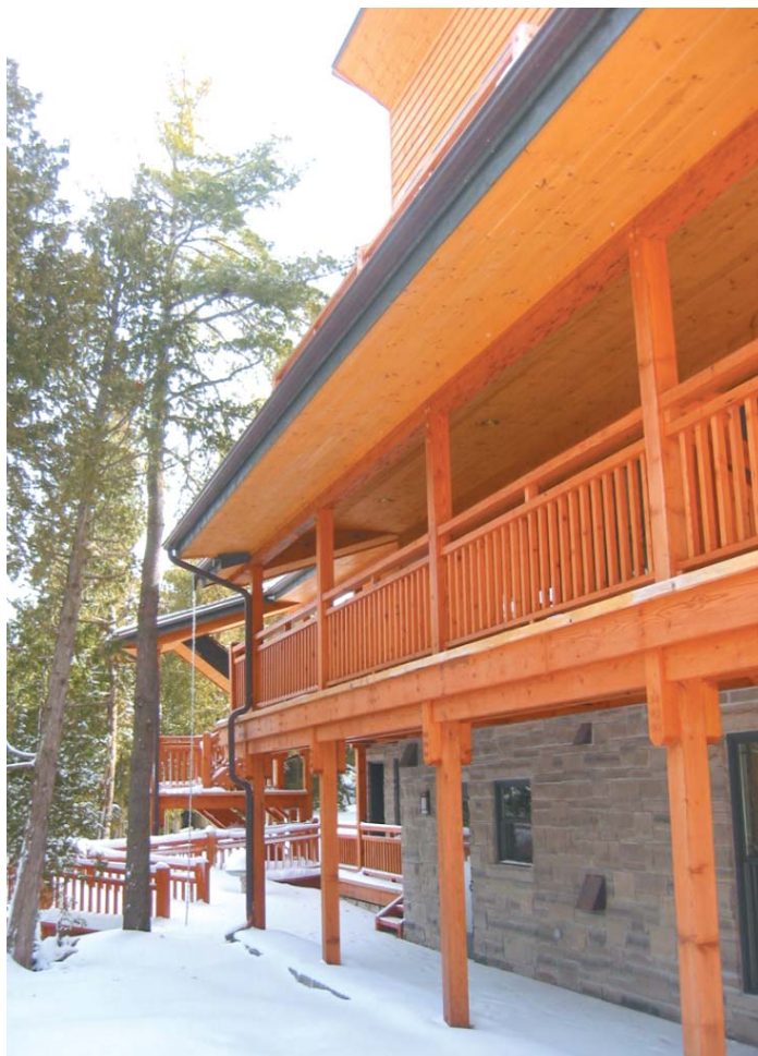
L'extérieur du bâtiment se distingue par ses solins, gouttières et appareils de plomberie en cuivre.
