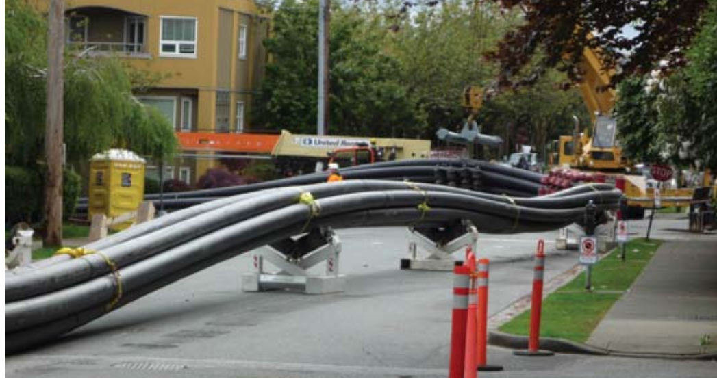
Gaines de câble construits en vue de la pose des câbles sous le bras de mer False Creek.
