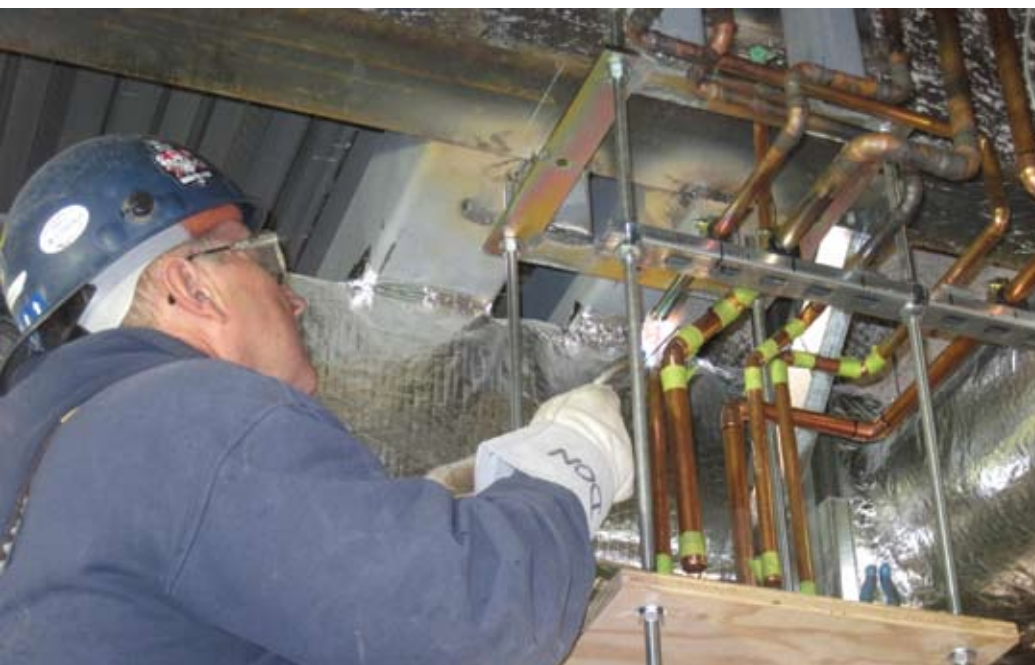
Une personne du métier de Lockerbie & Hole brasant un joint sur une conduite pour gaz médicaux. Le ruban apparaissant sur les joints voisins sert à protéger les joints pré-nettoyés et pré-assemblés. Il est retiré immédiatement avant le brasage.
