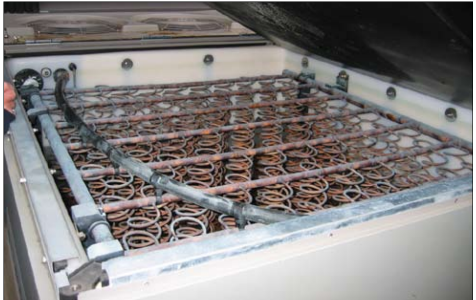
Serpentins en tube de cuivre ACR à l'intérieur de chaque appareil.
