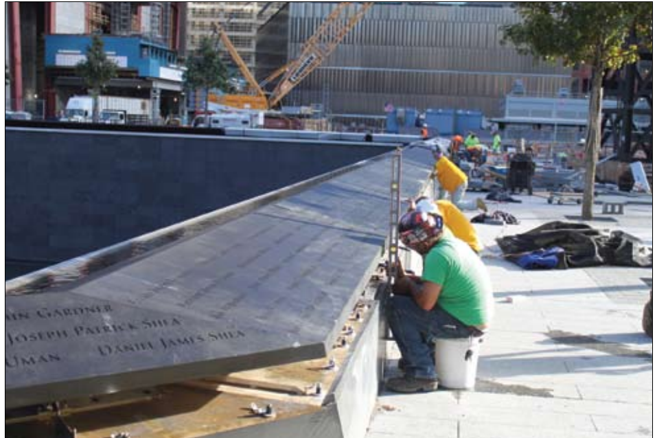
Cette photo prise durant la pose des panneaux montre l'envergure du site commémoratif.
