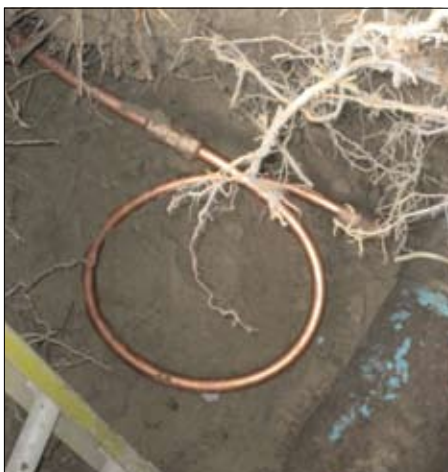
Le travail terminé au niveau de la canalisation d'eau. The completed installation at the water main.
