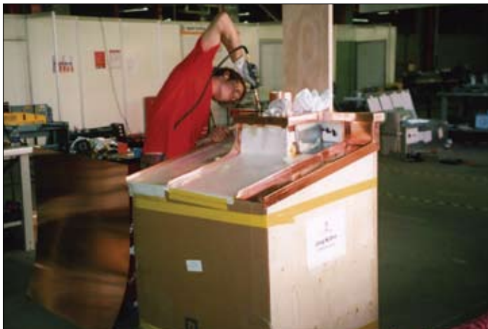
Fabrication de cuivre durant la compétition de réalisation de toitures métalliques.
