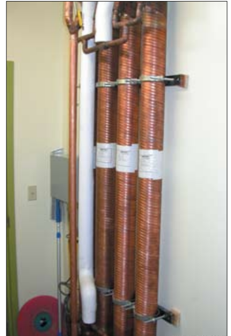
Quatre échangeurs thermiques Power-Pipemc posés à l'usine de sauce à spaghetti Unilever Ragu.
