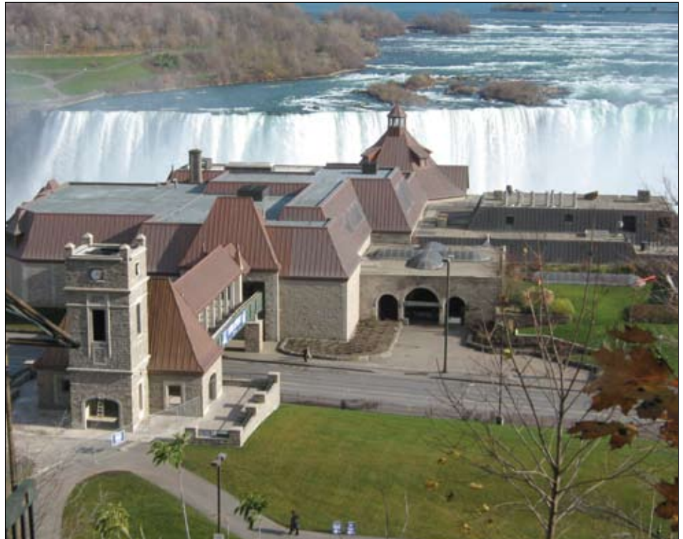
Le complexe terminé, avec les chutes en toile de fond. Photo : Custom Cupola & Steeple Co. The completed project with the Horseshoe Falls in the background.
