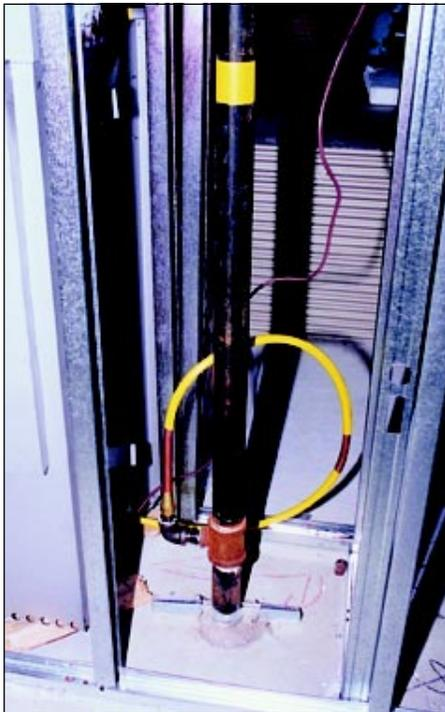
*La conduite d'alimentation de gaz naturel en cuivre est reliée à la conduite principale en acier à l'aide d'un raccord en laiton évasé.*
