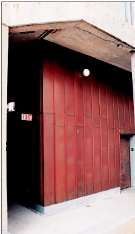
On a posé les feuilles de cuivre sur un tablier de placoplâtre soutenu par des poutrelles et recouvert d'une membrane et d'un papier de construction pour permettre au cuivre de se contracter librement.
