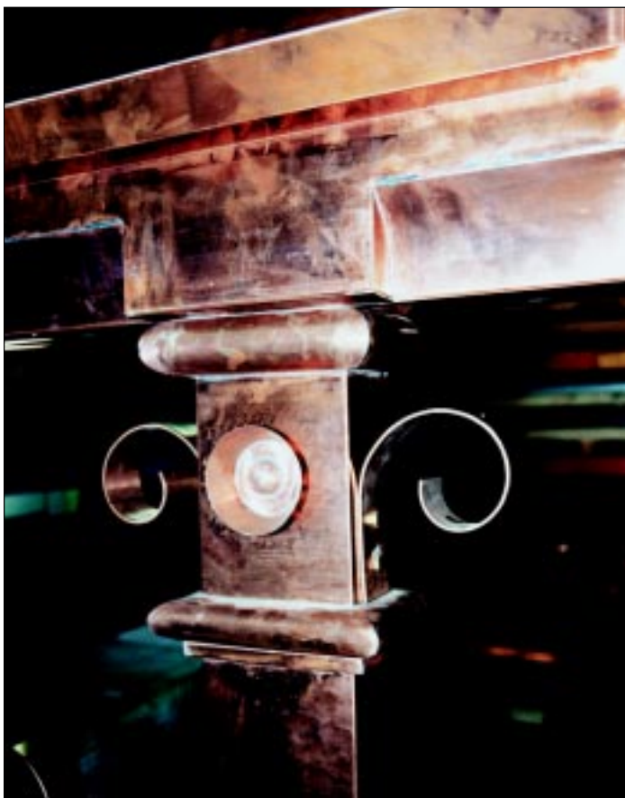
Ce détail de la rampe à la tour de Harvard montre les diverses méthodes de fabrication et les matériaux utilisés tels que les feuilles et les barres de cuivre.
