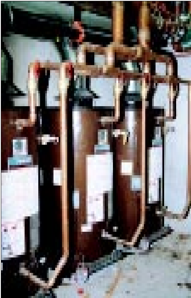
▲ Figure 1: Types de boucles de compensation et de lyres de compensation
